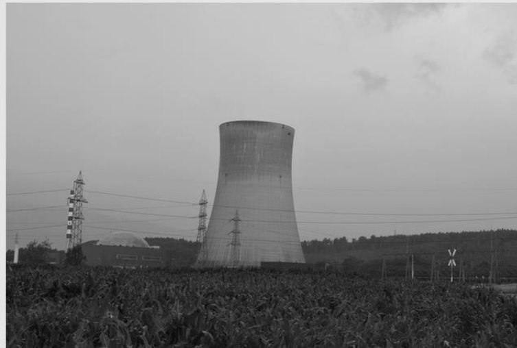
Reparatur einer Dampfleckage: Das AKW Gösgen produziert zurzeit keinen Strom. (Bild vom 29. Juni 2011)
